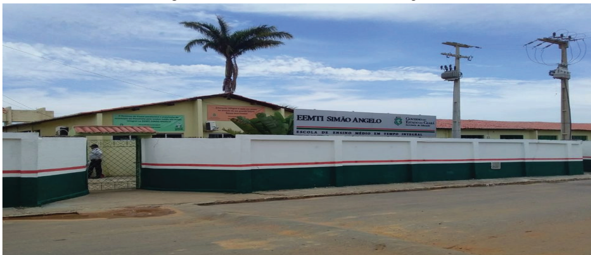
Figura 3 – Fachada da escola estadual Simão Ângelo.
